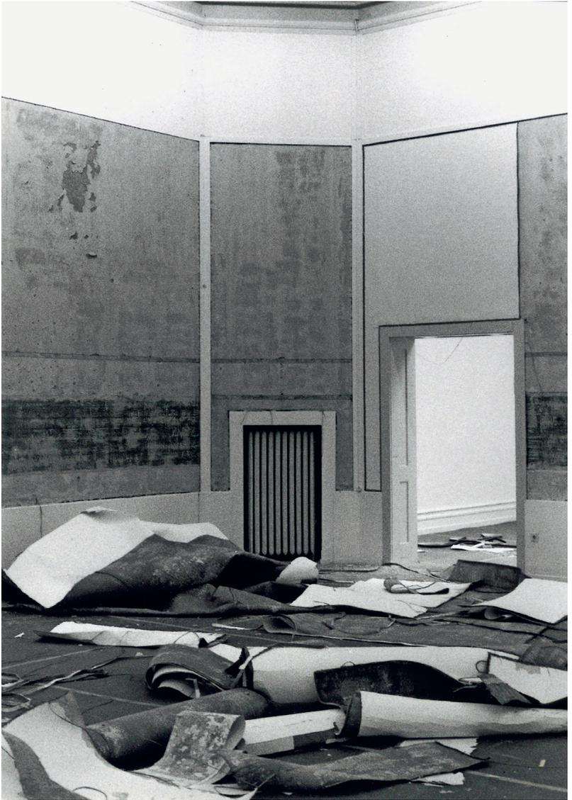
Entfernung der Tapeten und der erhöhten Sockelleisten im Hauptsaal. Umbau 1988.
